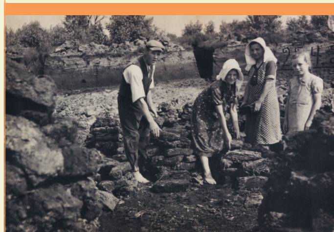
Beim Ringen, dem Umstapeln der halbtrockenen Torfsoden wurden die Soden bienenkorbformig „aufgeringt“. Solche leichteren Arbeiten mussten auch die Kinder mit verrichten. Das aus den 30er Jahren stammende Foto zeigt die Familie B. Voß aus Vörden mit Kindern.
