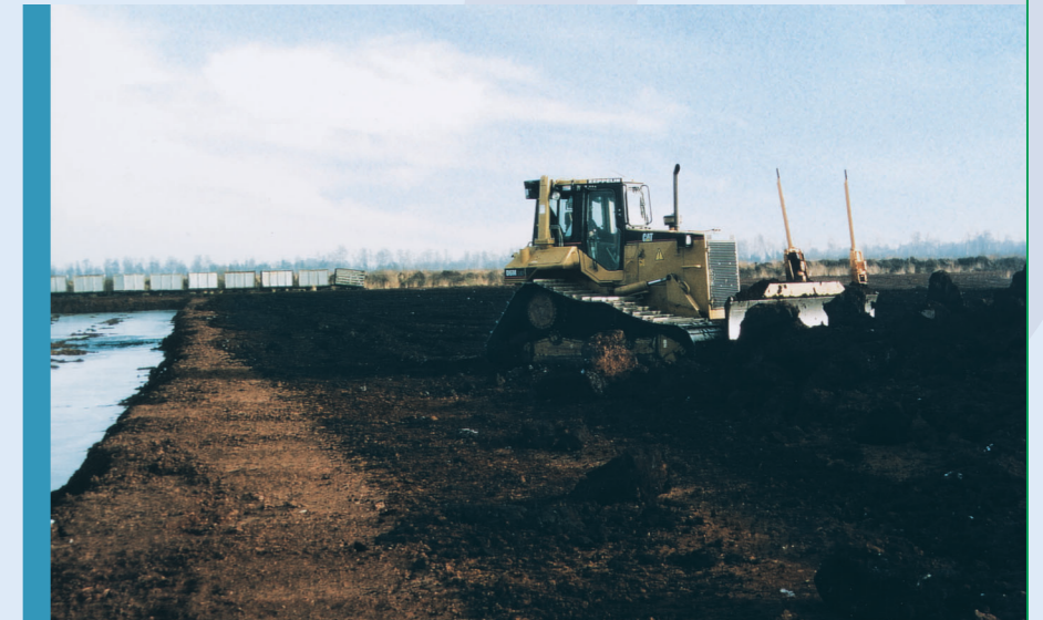
2. Auseinanderplanieren des ausgebaggerten Torfes.
