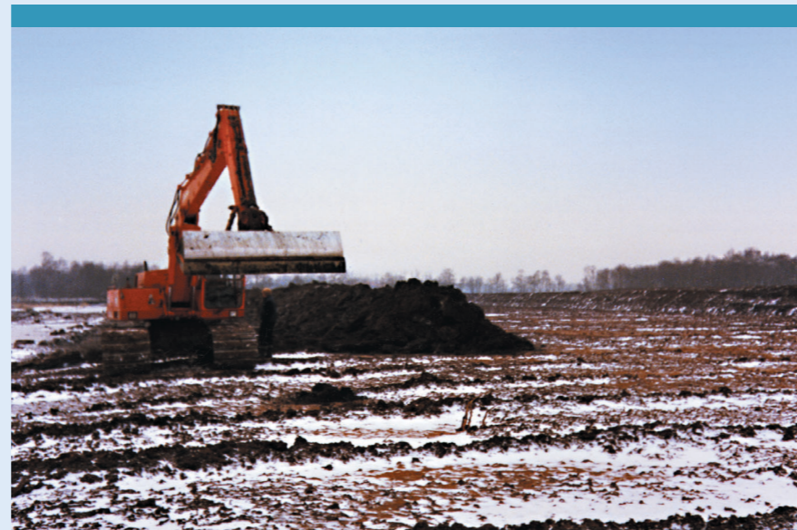
1. Ausbaggern bis auf die genehmigte Abtortungstiefe.
